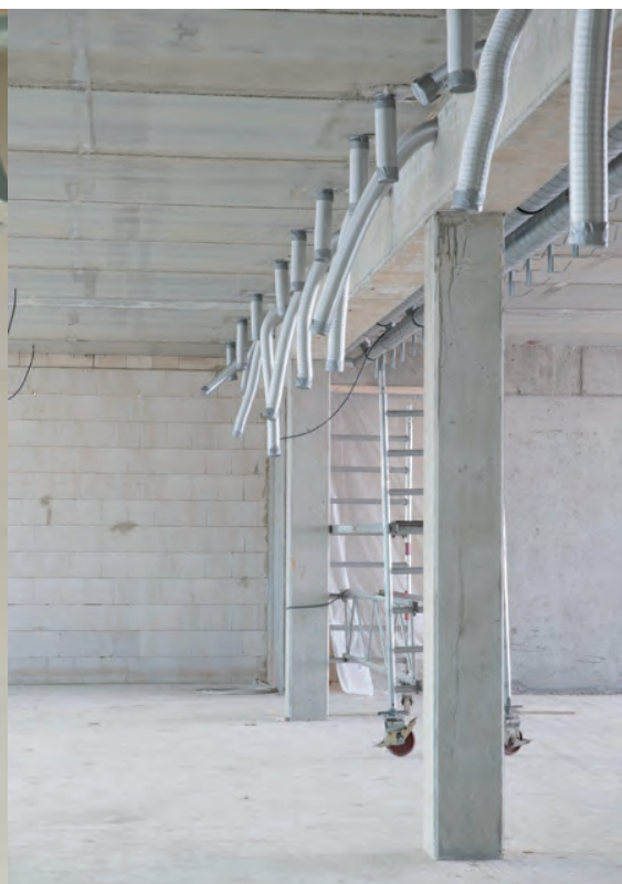
Die Räume sind in unterschiedliche Bereiche gegliedert, haben im engen Raster Zu- und Auslässe und bekommen die Luft automatisch optimal zugeteilt.
