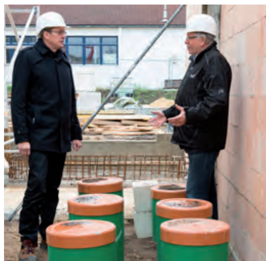
Eintritt Außenluftansaugung in Erdwärmetauscher Marco Vechtmann, DGNB-Auditor (l.), Norbert Niemeyer, TGA (r.)
