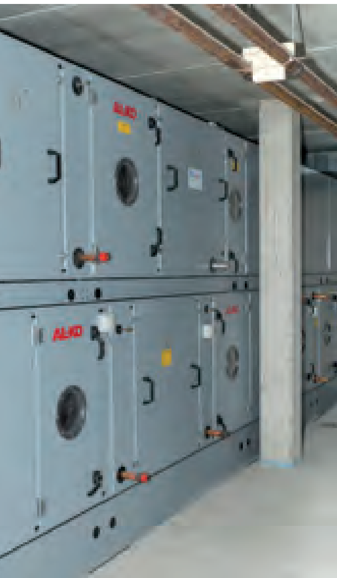
Kombiniertes Zu- und Abluftgerät 11.000 m 3 /h von AL-KO-THERM
