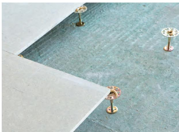
Während Doppelböden in der Regel aus Platten bestehen, die einzeln aufnehmbar sind, können Hohlraumböden über Revisionsrahmen und Elektrotanks überall Zugänglichkeiten zu Kabeln und Elektroleitungen ermöglichen. Im Stadtwerke-Neubau galt es, rund 1.900 Quadratmeter Fläche mit Nass-Hohlraumböden auszustatten.
