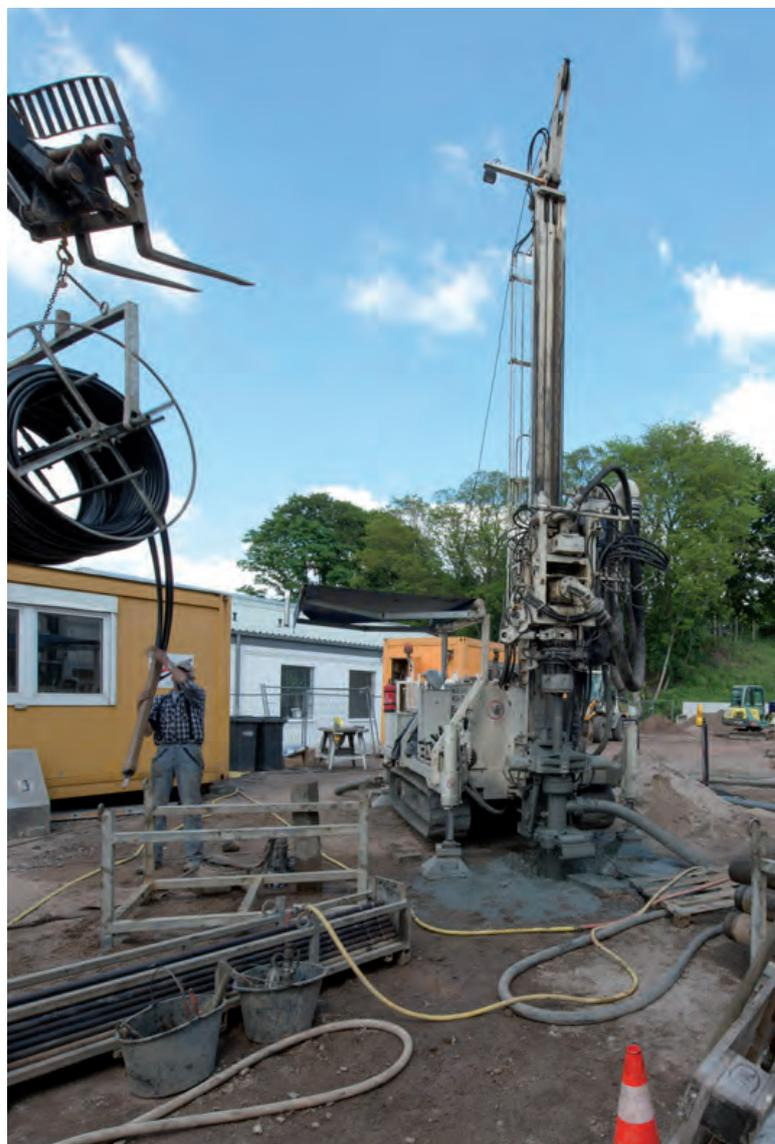
Erdbohrungen zum Einbau der Erdwärmesonden
